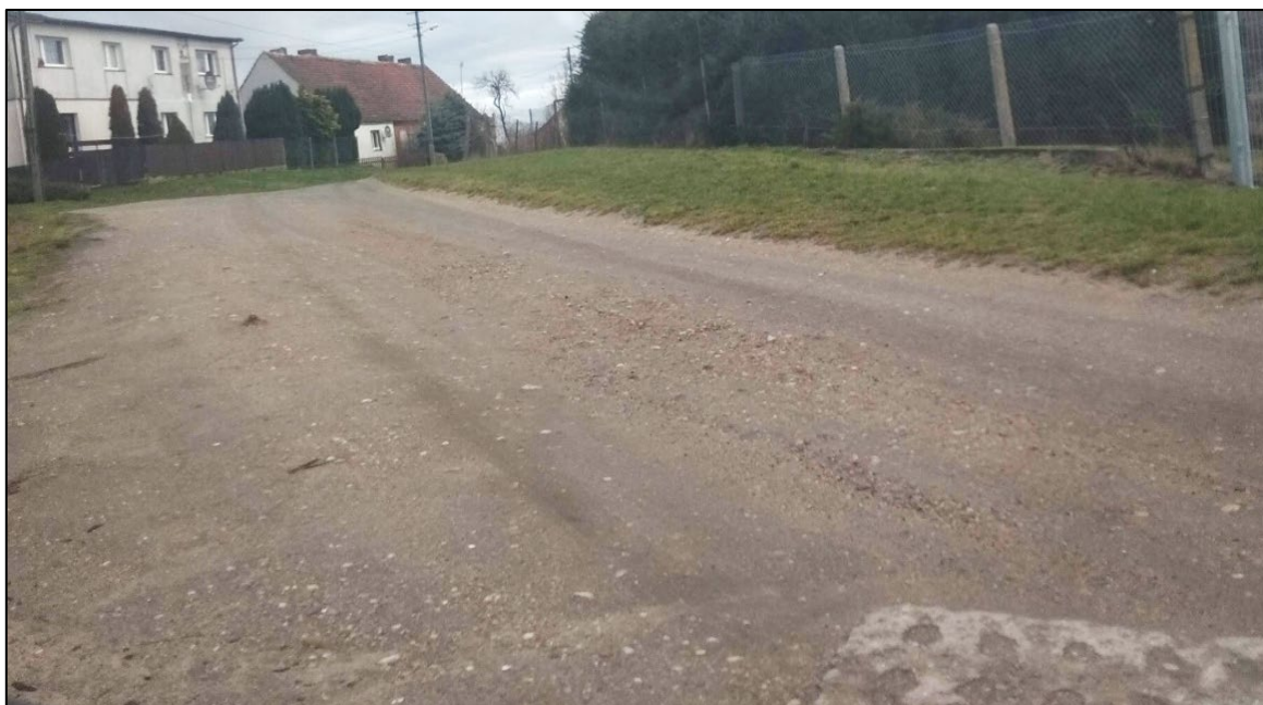
Fot. Stan istniejącej drogi
