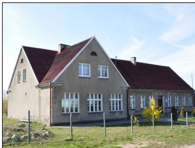
Fot. Budynek dawnej szkoły
