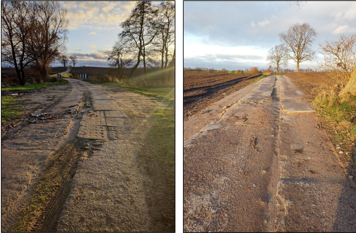
Fot. Stan istniejącej drogi
