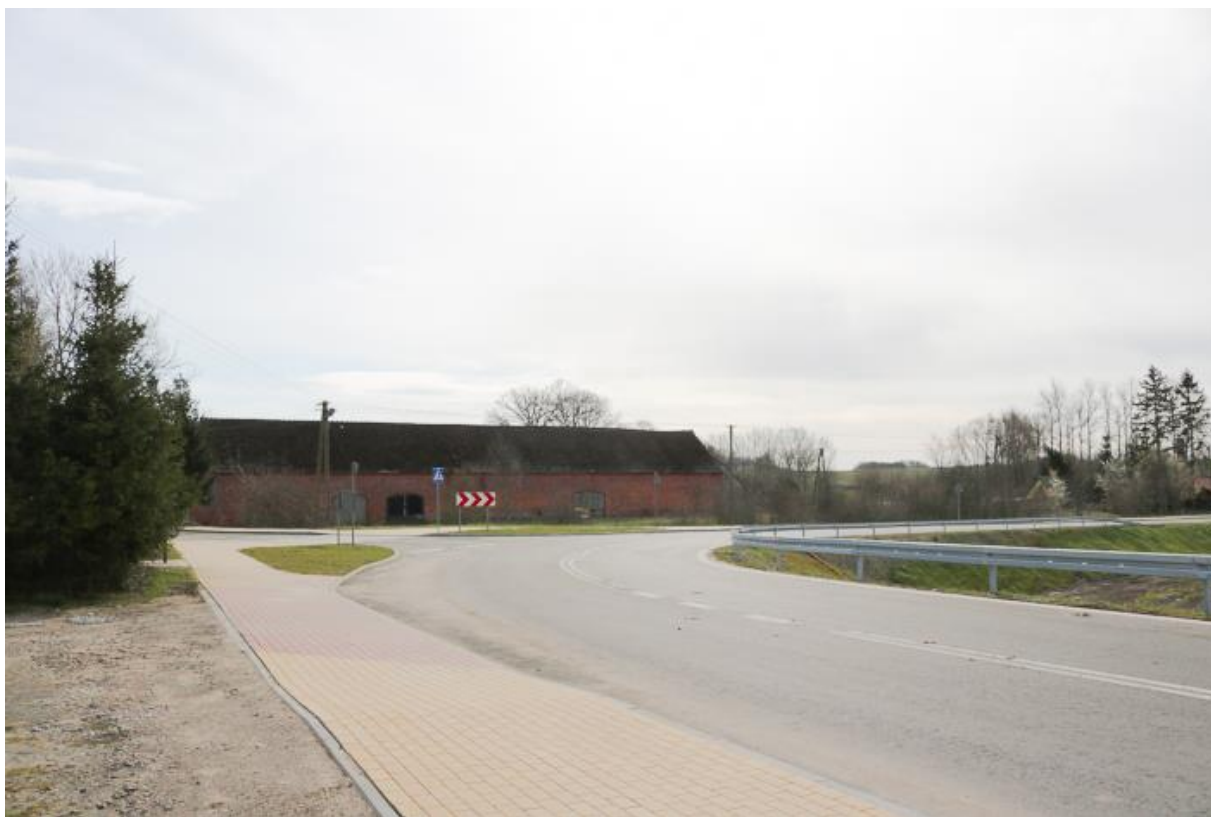
Fot. 16 Przebudowa drogi Borkowice - Śmiechów – Kładno – Pleśna Etap Ia: przebudowa drogi Borkowice – Śmiechów Źródło: Archiwum własne
