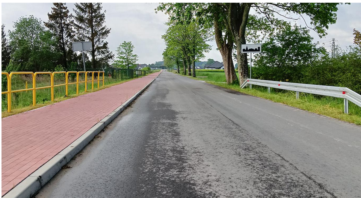
Fot. 31. Droga Dobieślawiec-Mścice Źródło: Archiwum własne
